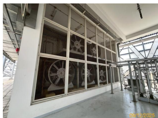
รูปที่ 2-36 พัดลมระบายควัน บริเวณชั้นหลังคา
