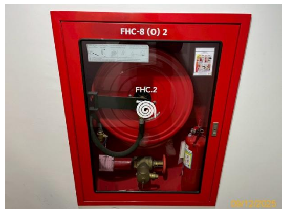
รูปที่ 2-30 ตู้เก็บสายฉีดน้ำดับเพลิง
