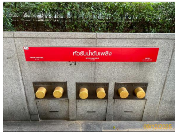
รูปที่ 1-9 หัวรับน้ำดับเพลิง ส่วนสำนักงาน และส่วนของโรงแรม
